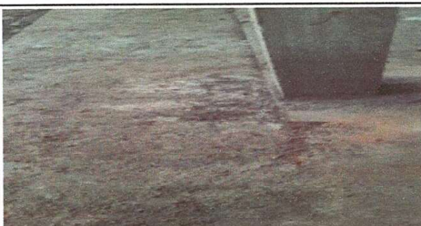
Foto 5: Se observa una de la columna del Edificio escolar concluido
