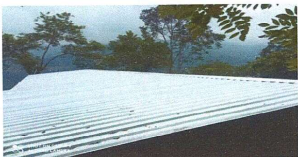
Foto 3: se observa el edificio escolar concluido
