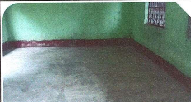
Foto 4: Se Observa el Piso de las aulas concluido
