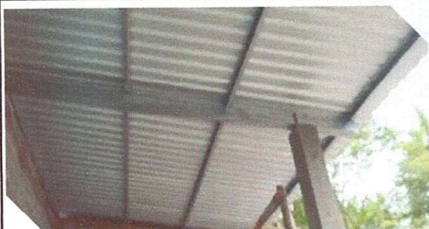
Foto 1: Se observa las costaneras de las laminas troqueladas de las aulas concluido
